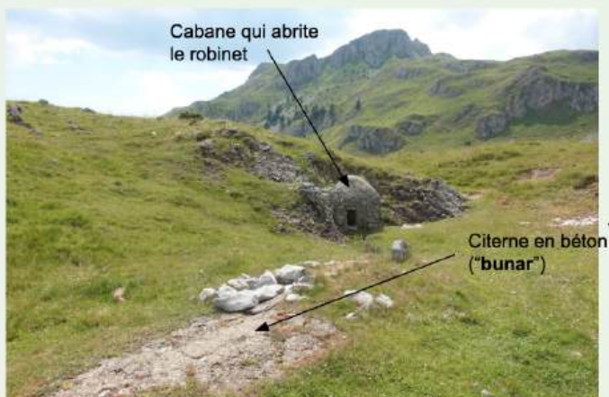
Source aménagée avec bunar, robinet et abris, katun Bunarine (municipalité de Mojkovac), utilisé actuellement
