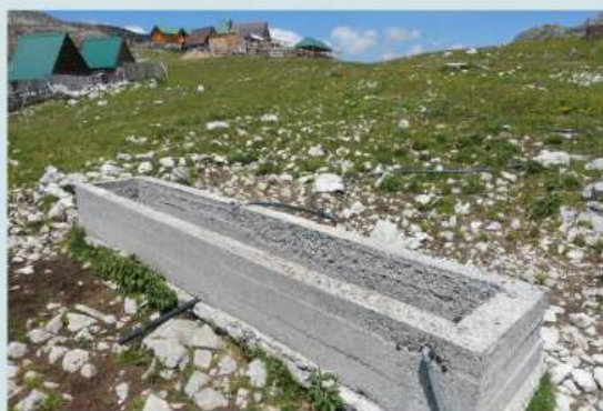
Abreuvoir en béton, alimenté par un tuyau qui capte l'eau depuis une source en amont, katun Ječmen Do (municipalité de Kolašin)
